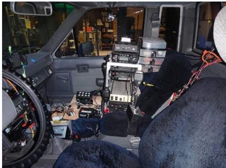
WW7D Rig Set Up
